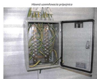
Príklad ochranného pospájania v objekte budovy:
